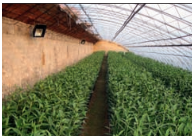
Различные сооружения защищенного грунта
